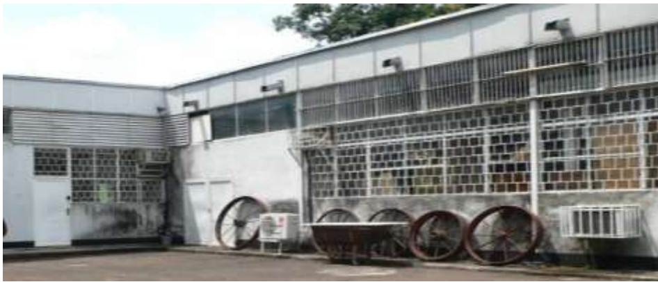
Fig 1 : Bâtiment de l'IMNC (Source : photo, D. Sita, 2018)
